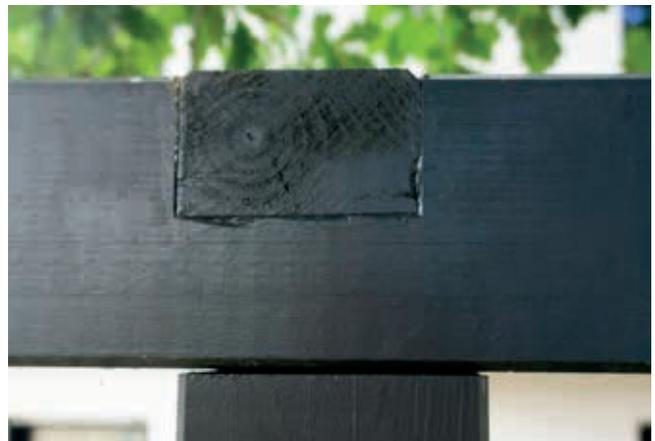
Hierfür erst die Ausschnitte für die Blattung fertigen und dann die äußeren Balken auf die Stützen und gemäß den Ausschnitten ineinander legen und dann mit den 160er Spax\* verschrauben. Das geht am besten zu zweit.
